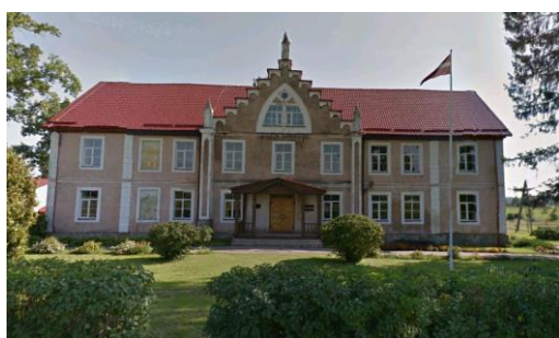
33.attēls. Malienas pamatskola
